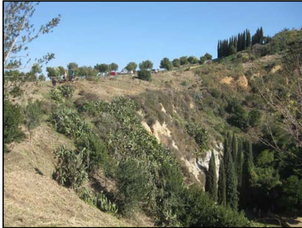
FOTO 1. Vista general del sector nord de la intervenció.
