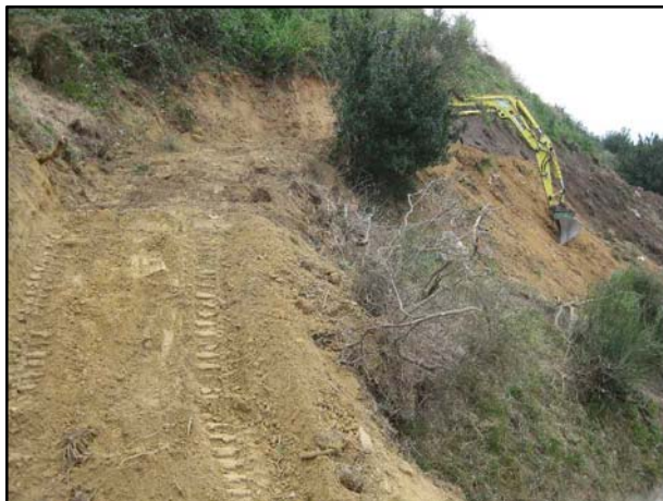
FOTO 11. Adequació d'un accés de manteniment en la zona sud-est de la intervenció.
