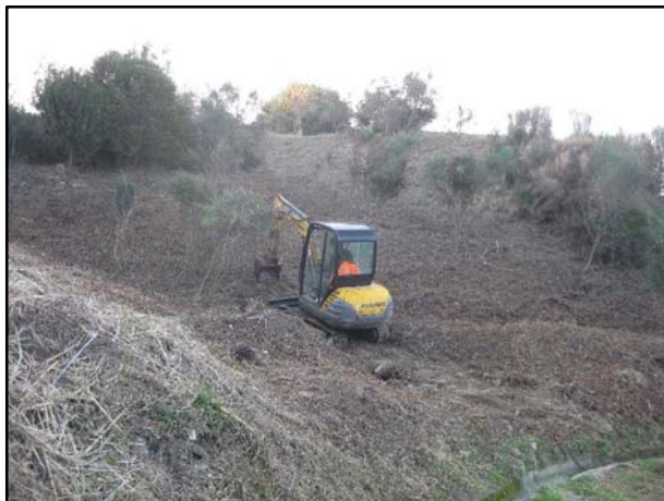
FOTO 7. Inici dels treballs mecànics en la zona su-est de la intervenció.
