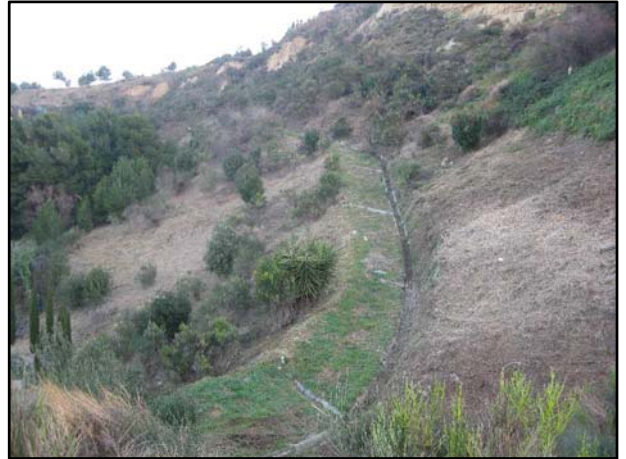
FOTO 6. Vista general del sector sud-est de la intervenció.
