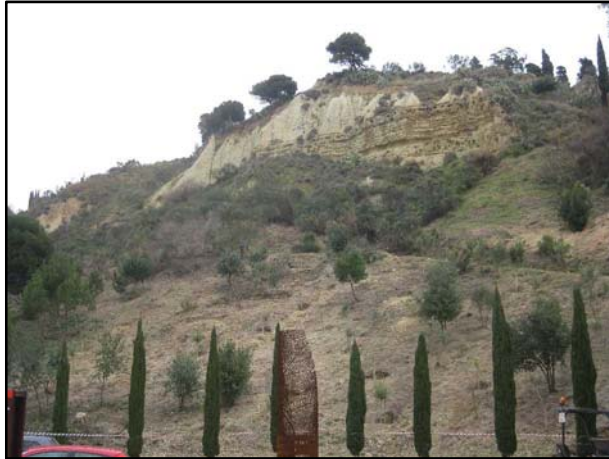
FOTO 5. Vista general del sector sud-est de la intervenció.
